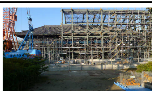
↑ すやね た じょうきょう じょうきょう 素屋根を建てている状況
